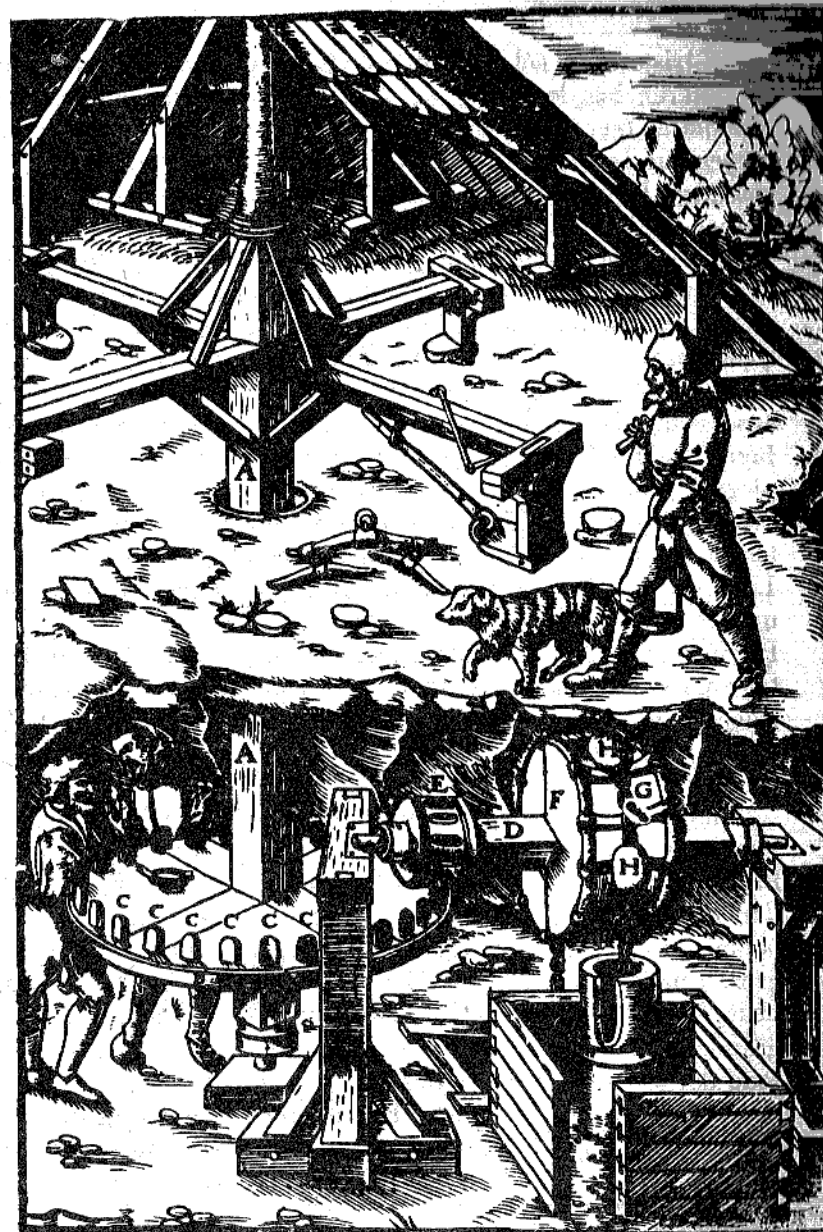
Extracción de agua de una mina. Siglo XVI. G. Agrícola.
